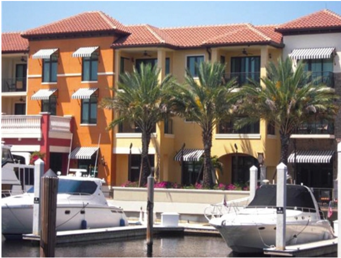
Komplettansicht des Objekts in Naples
